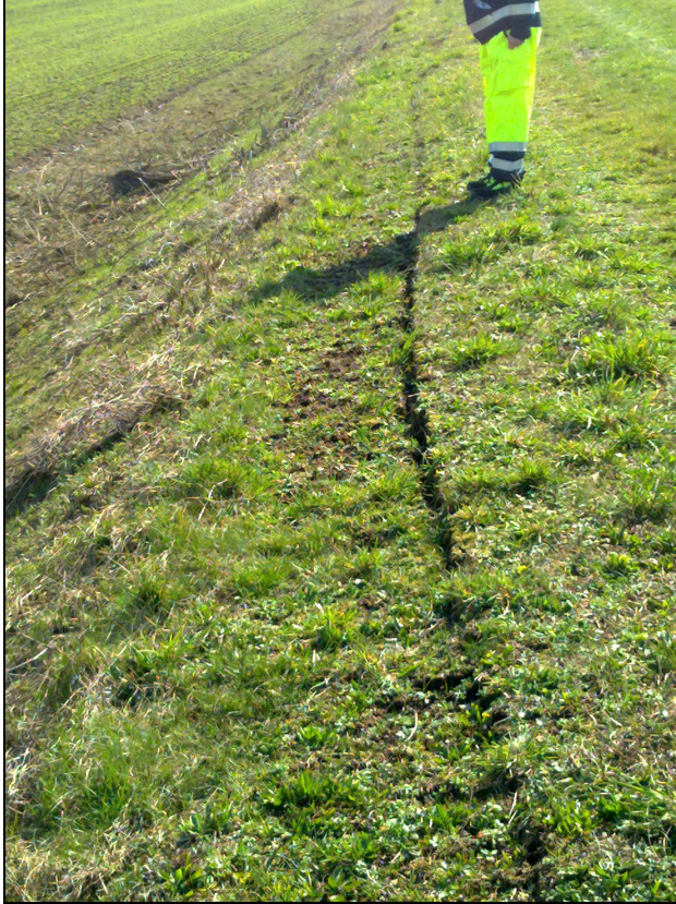
Foto 1: le crepacciature lungo l'argine (lato fiume)
