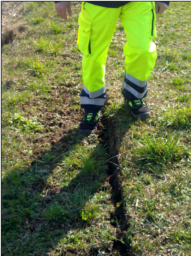
Foto 3: ribassamento del ciglio dell'argine (lato fiume)
