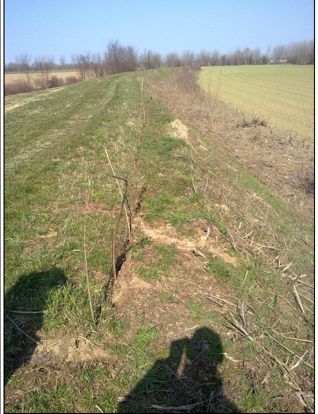
Foto 2: le crepacciature, evidenziate da bastoncini infissi dai volontari di Protezione Civile
