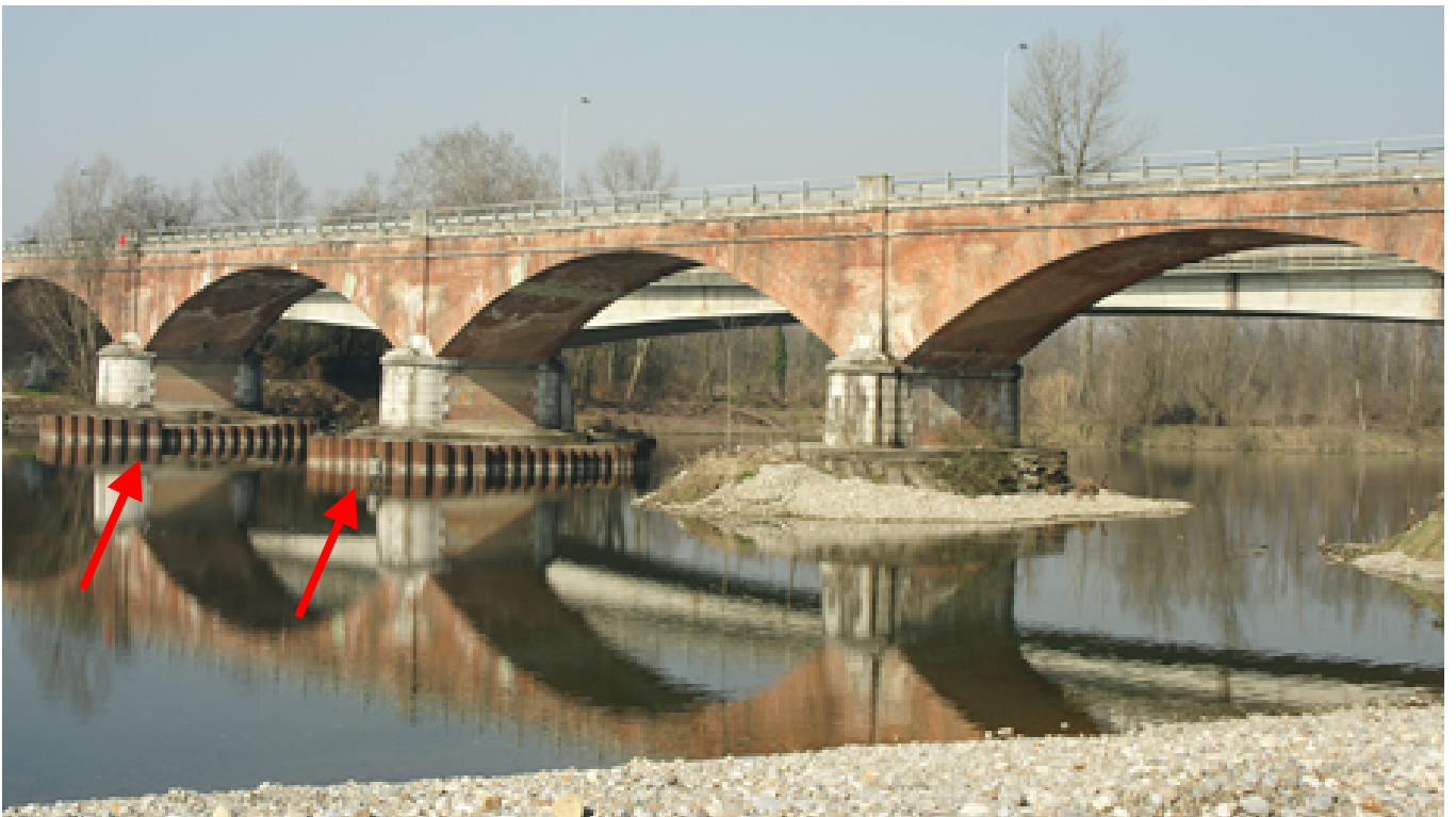
Cerchiatura mediante palancolato
