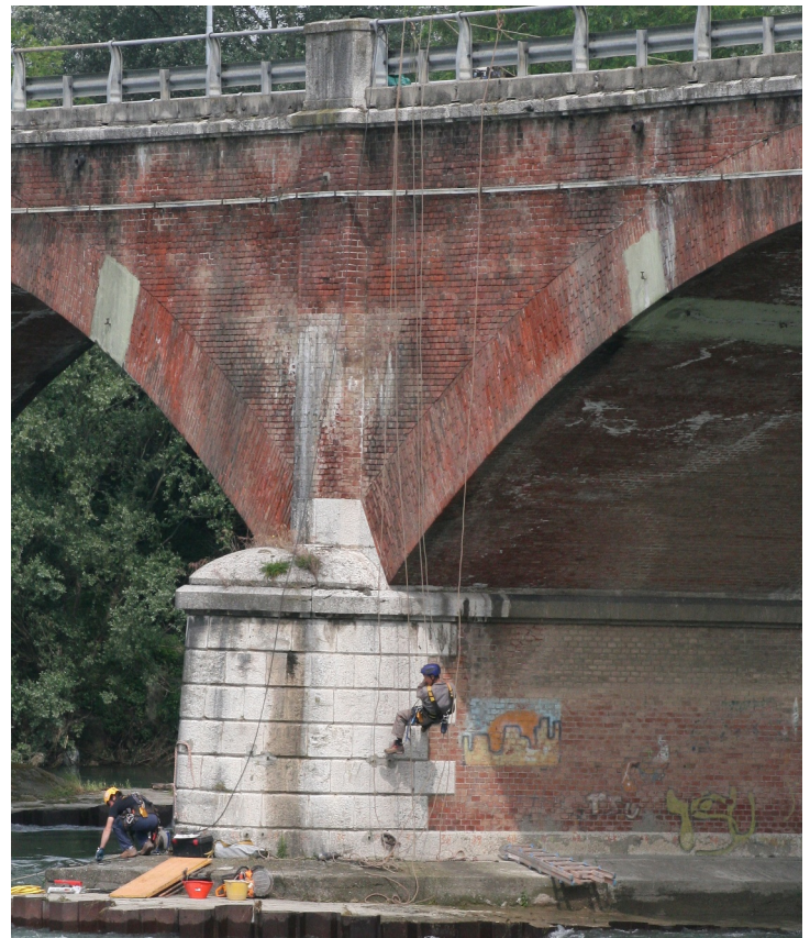
Ispezione con sonda televisiva nel foro del carotaggio C1 e ripresa fotografica delle fasi di preparazione delle prove nella pila 3
