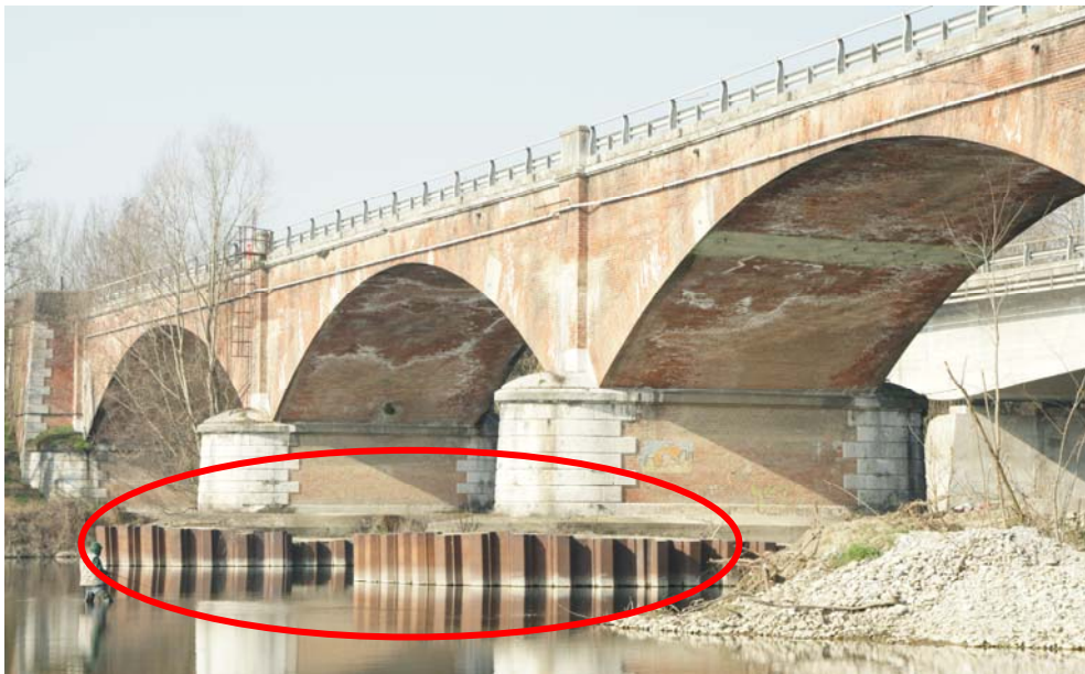
Fig. 2.2.7 – Consolidamento delle pile 3 e 4 mediante palancole.
