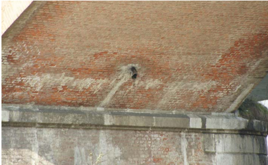
Fig. 2.2.3 – Doccione di scarico delle acque.
