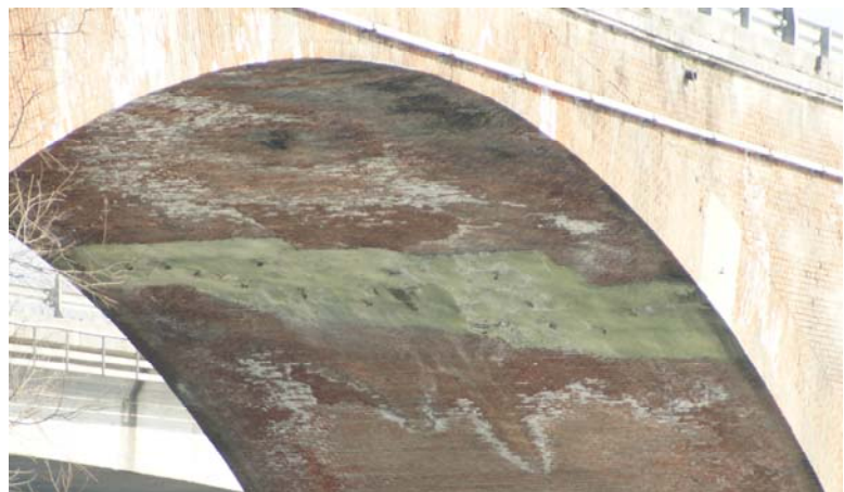
Fig. 2.2.2 – Intervento di ripristino della zona fessurata in seguito al cedimento della pila 3.
