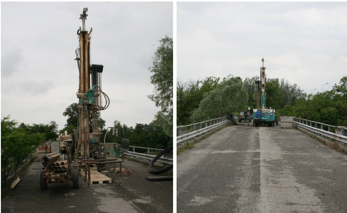
Figura 1. Esecuzione del sondaggio a carotaggio continuo SI, diametro 100mm con sonda geotecnica.
