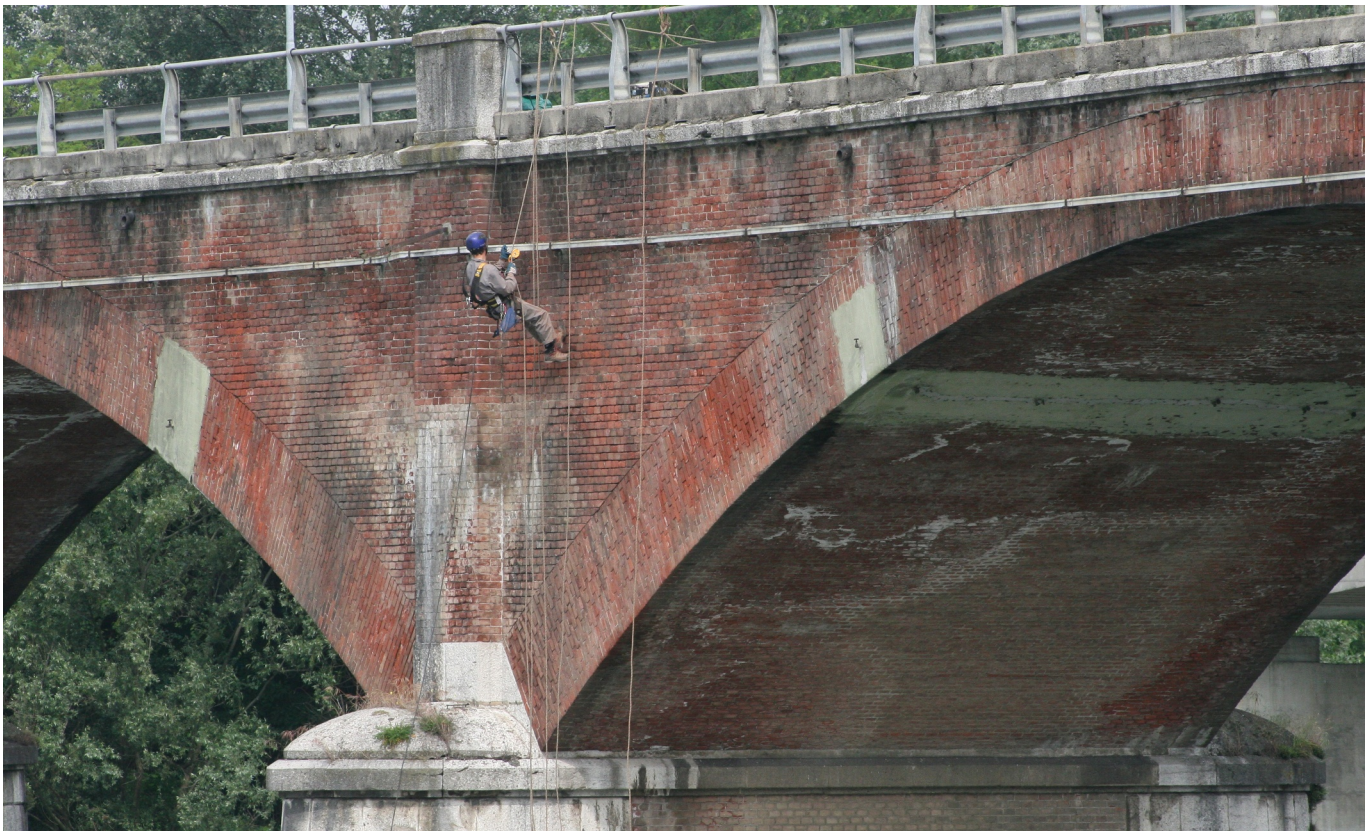
Ripresa fotografica della calata alla base della pila 3
