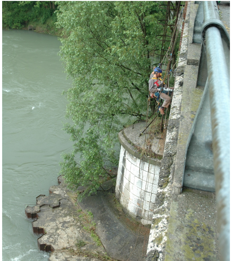
Fasi preparatorie per l'esecuzione del carotaggio C4 nella pila 4
