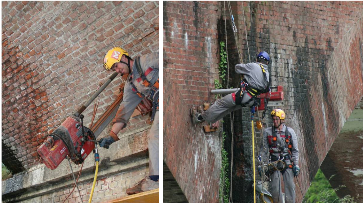
Figura 2. Esecuzione dei carotaggi meccanici sulle murature in elevazione mediante l'assistenza di rocciatori
