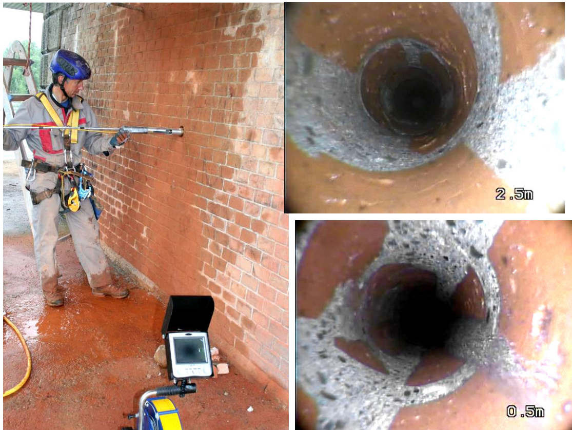
Figura 3. Prospezione con sonda televisiva all'interno dei fori dei carotaggi
