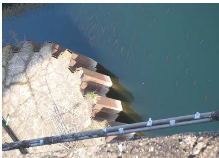
Fig. 2.2.8 – Cintura di palancole e calcestruzzo alla base di una delle pile del ponte storico di Bisnate
