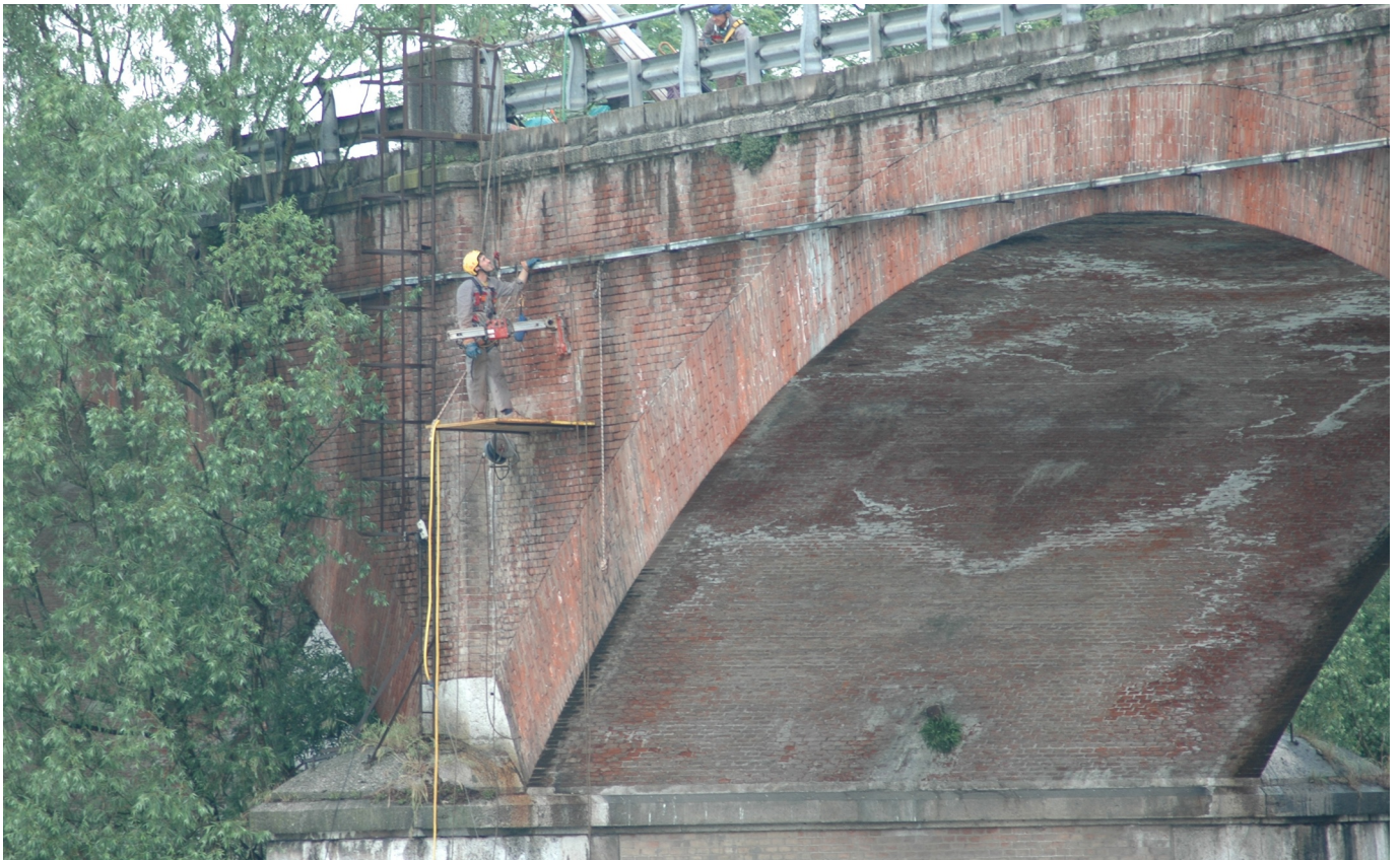
Fasi di esecuzione del carotaggio C4
