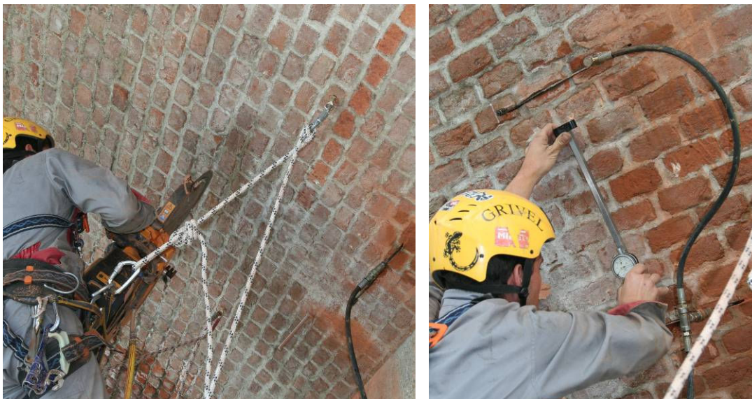
Figure 6 e 7. Fase di esecuzione della prova con martinetti piatti paralleli per la determinazione delle caratteristiche di deformabilità delle murature
