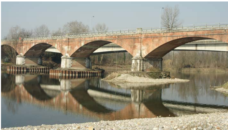
Fig. 2.2.1 – Vista d'insieme del ponte.
